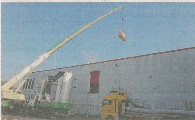
Hoch hinaus: Mit einem Spezialkran wird das BHKW-Aggregat über das Dach der Heizzentrale an seinen Standort gehievt.
